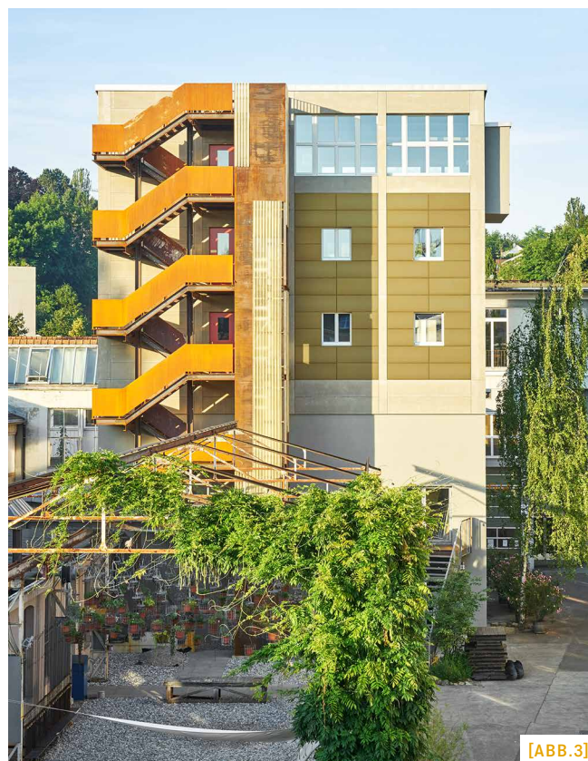
[ABB.2] Lysbüchel Basel: Innenhof. Fassade im Obergeschoss aus vorfabrizierten Holzrahmenelementen und den Lagerfenstern / Lysbüchel, Bâle: cour intérieure. Façade des niveaux supérieurs en éléments d'ossature bois préfabriqués et fenêtres de déstockage / Lysbüchel, Basilea: cortile interno. Facciata del piano superiore di elementi prefabbricati in legno a telaio e finestre rimaste invendute, recuperate dai magazzini
