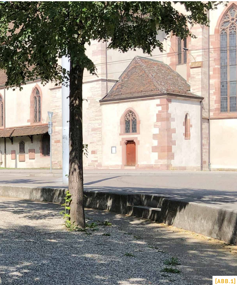
[ABB.1] Bücherschrank / Bibliothèque de rue / Biblioteca di strada (Foto: Norbert Ernst)
